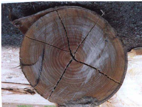
**Figura 7.** Representación de las fendas en el extremo de la troza.
