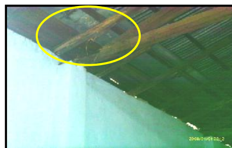
Figura 10. Estructura que sostiene la cubierta
