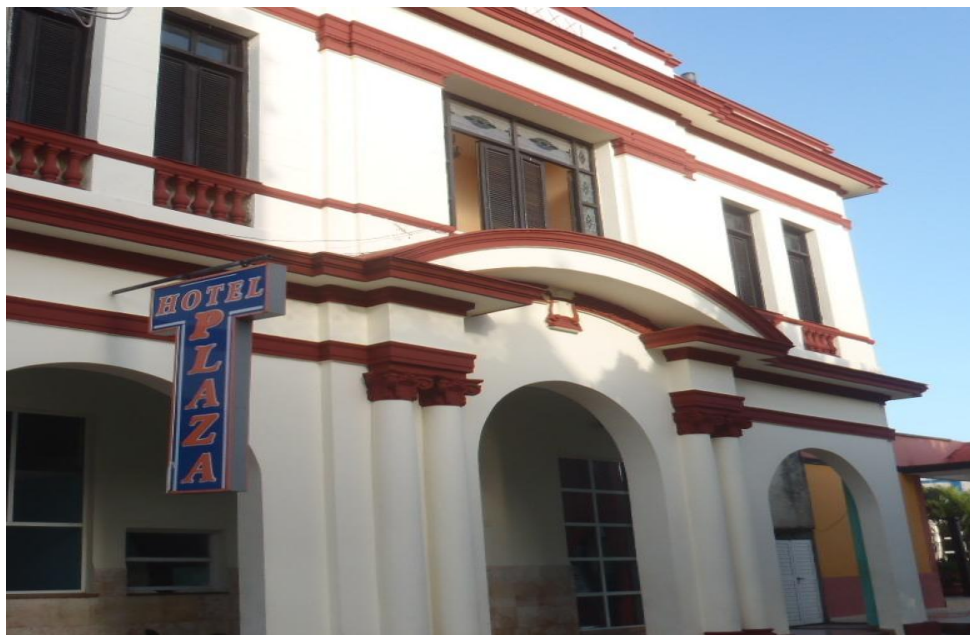
Figura 4 : Exterior del Hotel Plaza
