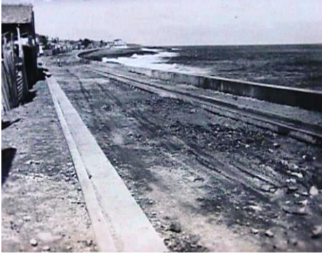
Construcción de Malecón de Baracoa.
