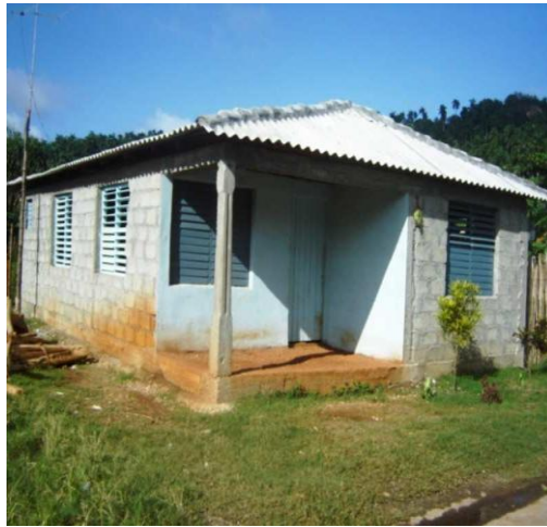
Vivienda denegada por el CITMA, Reparto Flora.
